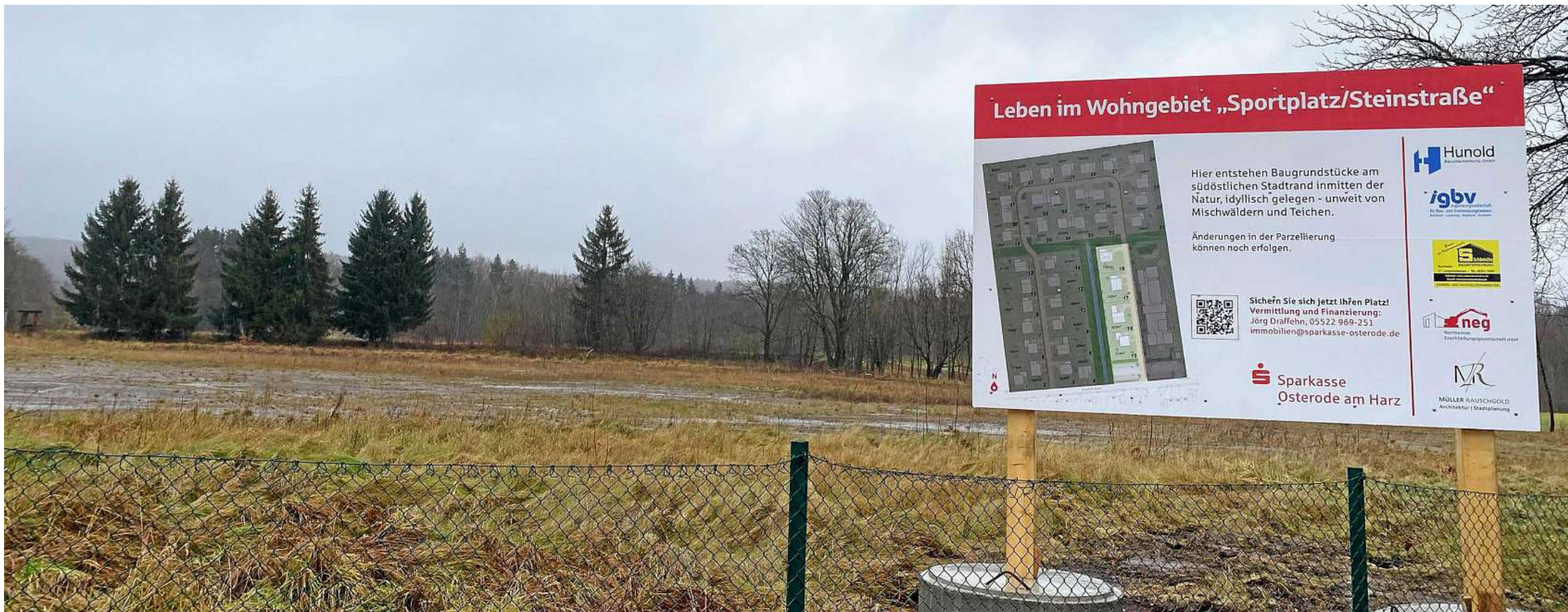
Neubaubereich Sportplatz/Steinstraße in Bad Sachsa
